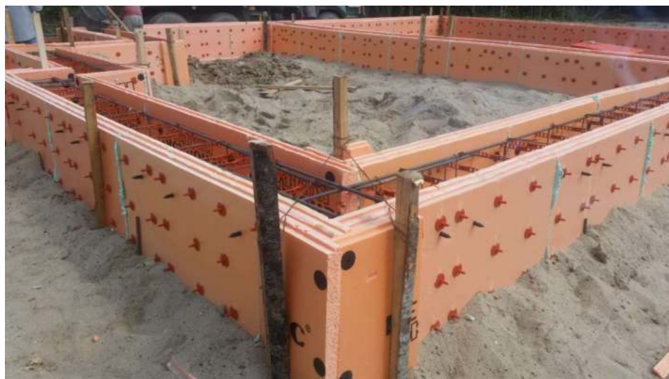
Рис. 4 Укрепление угловых элементов опалубки
