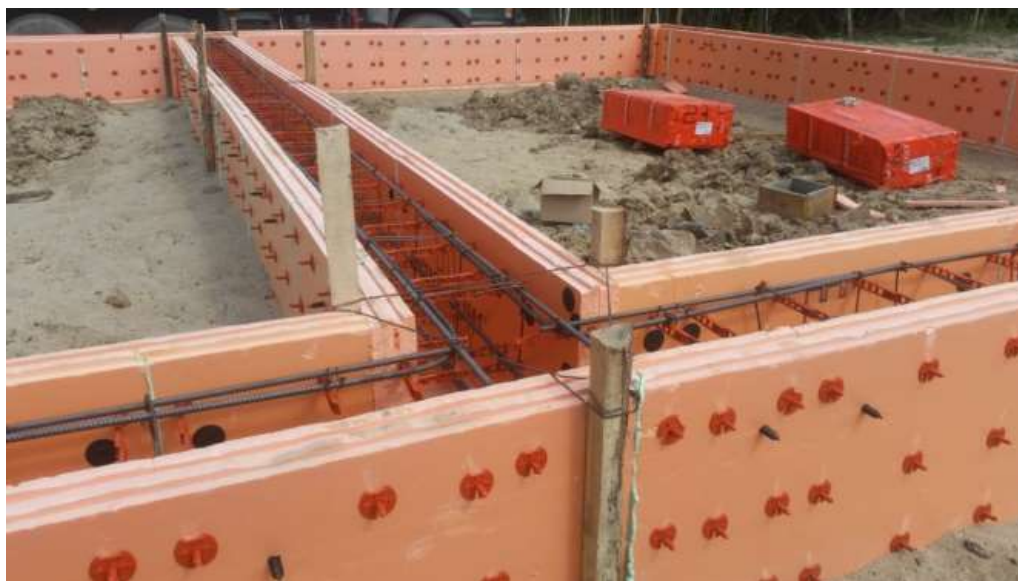
Рис. 6 Укрепление Т-образных углов опалубки
