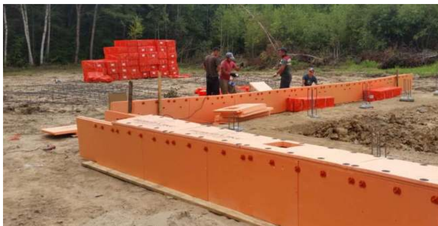
Рис. 1 Сборка несъемной опалубки
