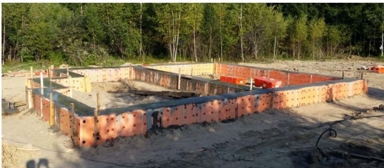
Рис. 7 Конструкция после заливки
